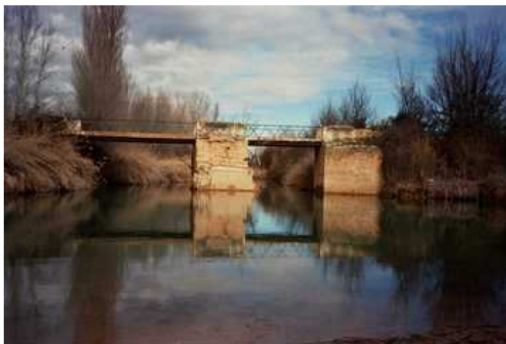
Puente de San Benito en la actualidad
